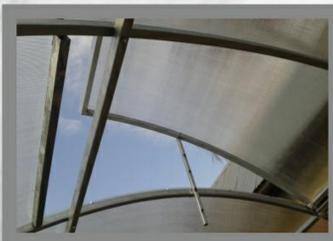
Форточка верхняя. Дополнительная форточка в крыше теплицы имеет уникальную конструкцию и способствует лучшему проветриванию больших теплиц (6 метров и более).
