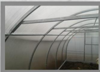
Распорка. Поперечная распорка изготовлена из оцинкованной трубы 30\*20. Увеличивает прочность конструкции и используется для подвязки растений (рекомендовано для теплиц 6 метров и более).
